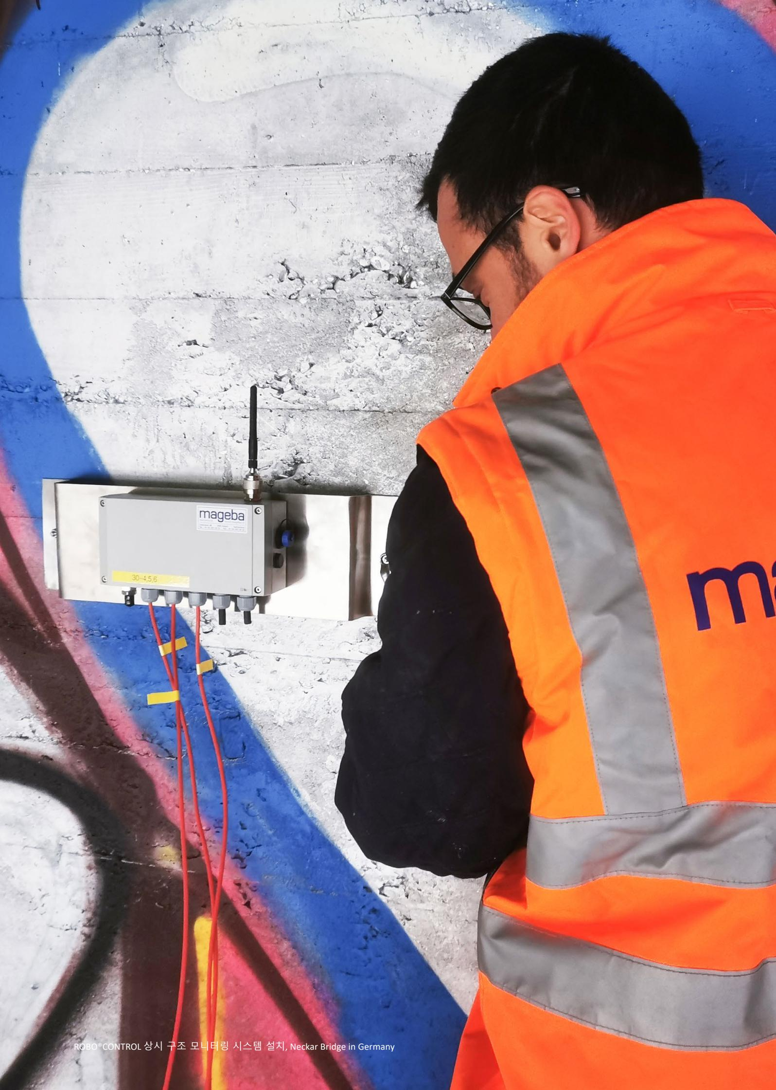
ROBO<sup>®</sup>CONTROL 상시 구조 모니터링 시스템 설치, Neckar Bridge in Germany
