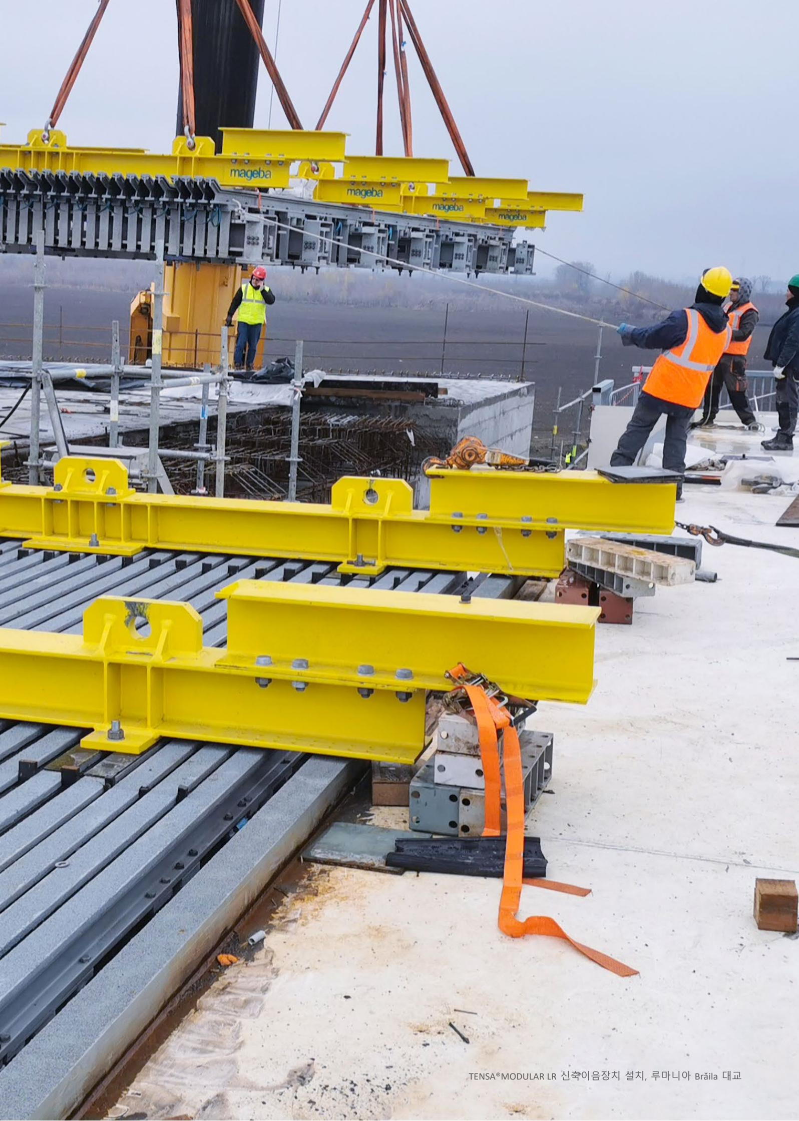
TENSA®MODULAR LR 신축이음장치 설치, 루마니아 Brăila 대교
