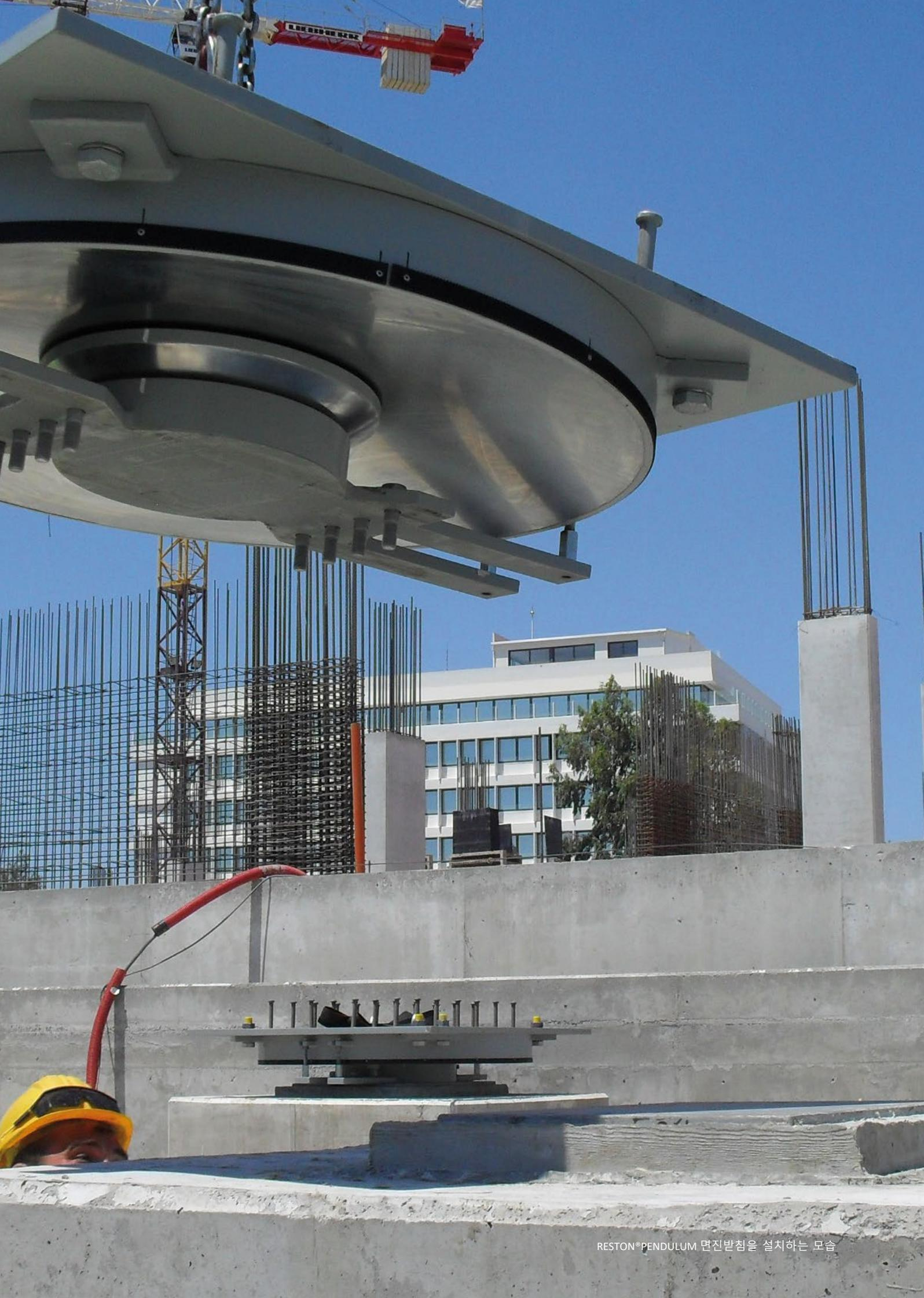
RESTON®PENDULUM 면진받침을 설치하는 모습
