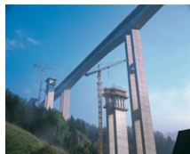
Talübergang Lavant (AT)
