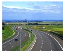
Autostrada Transilvania (RO)
