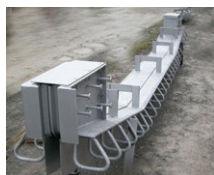
Dilatáció beszerelésre készen
