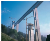
Talübergang Lavant (AT)
